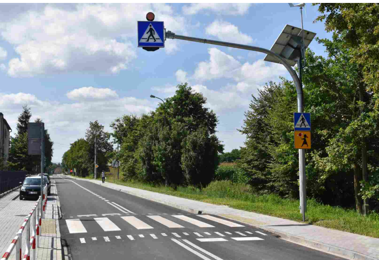
➤ Zakończony remont drogi powiatowej nr 1895K w miejscowości Las i Przeciszów
