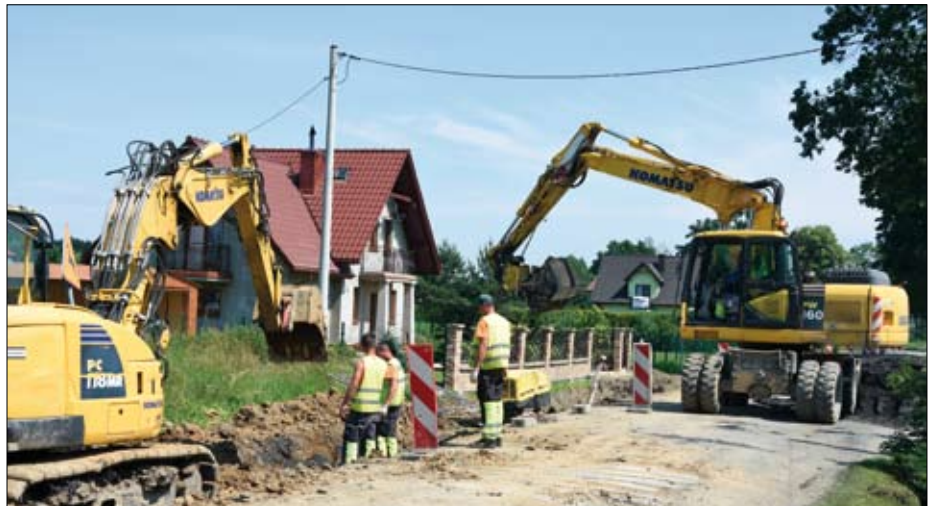
Tak wygląda zadanie, prowadzone na drodze powiatowej w Przeciszowie.
