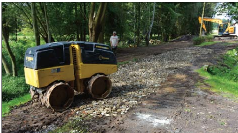
Rozpoczęto kolejny etap kanalizacji naszej gminy. Tym razem ciężki sprzęt wkroczył do Piotrowic. Na zdjęciu moment wykonywania prac na ulicy Pagórkowej.
