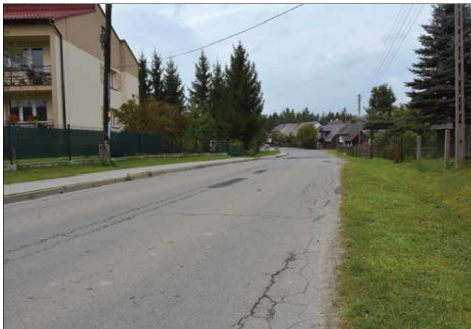
Tak wygląda ulica Podlesie w Przeciszowie. Dzięki podjętym staraniom przez naszą gminę będzie ona gruntownie wyremontowana, podobnie jak ulica Leśna.
