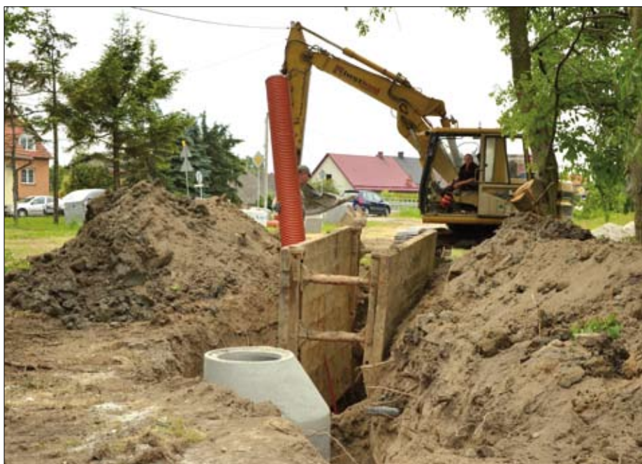
Podczas kanalizacji sołectwa Przeciszów prace szły pełną parą. Ten widok jednak jest już historią. Przed nami kanalizacja Piotrowic.
