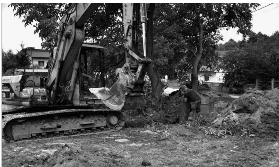
Prace związane z powstaniem kanalizacji - etap IV są zaawansowane i trwają obecnie w Przeciszowie. Wykonano ok. 4.200 m sieci kanalizacyjnej.
