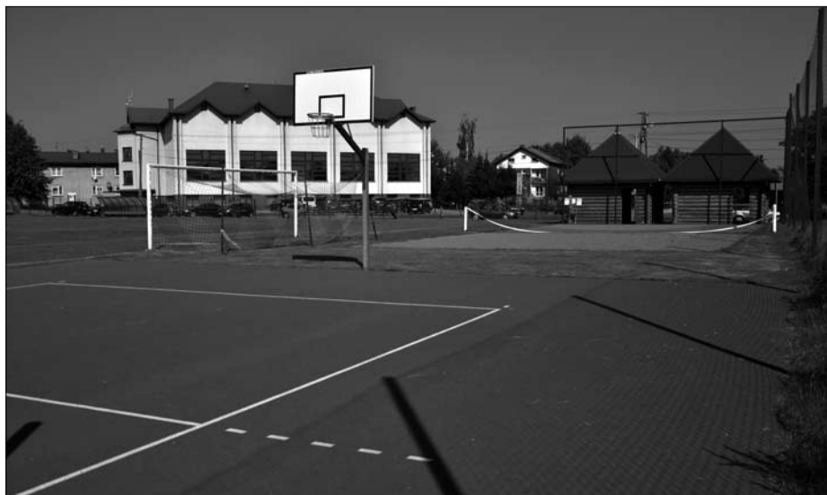
Budowę kompleksu sportowego w szkole w Piotrowicach zapoczątkowało powstanie boiska wielofunkcyjnego i kortu tenisowego.
